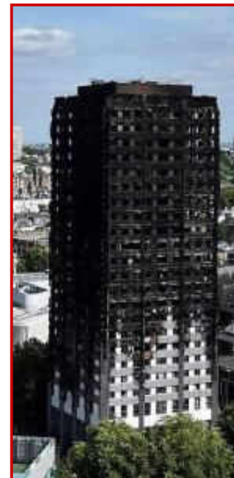
Torre Grenfell, Londres (2017)
